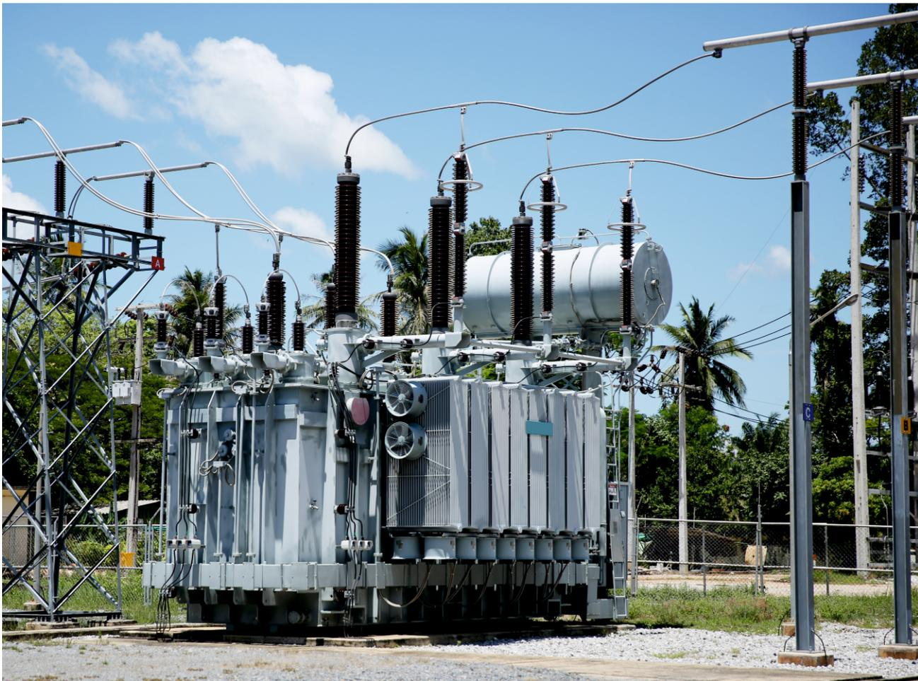
Главный распределительный пункт (ГРП) - это электроэнергетическая подстанция, питающая сеть ВН, в состав которой входят распределительные устройства ВН и НН, а также трансформаторы мощности.
